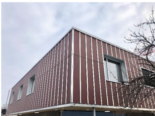
Foto: Die Fassadenanlage stellten die werke bereits Ende 2020 fertig.
