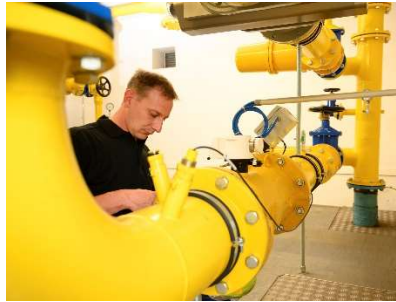
Kontroll- und Wartungsarbeiten in der Gas-Druckreduzier- und Messstation
