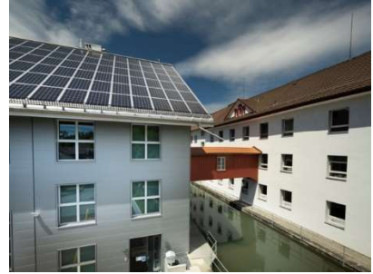
Solarstromproduktion in der Herzogenmühle
