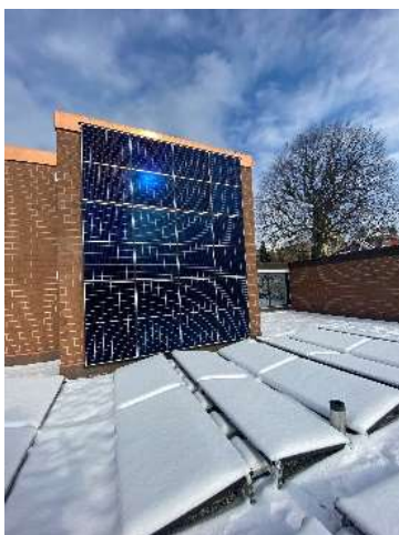
Bild 1: Dach- und Fassadenanlage nach Schneefall
