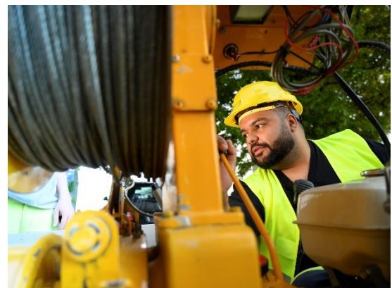
die werke -Netzelektriker am Stromnetz
